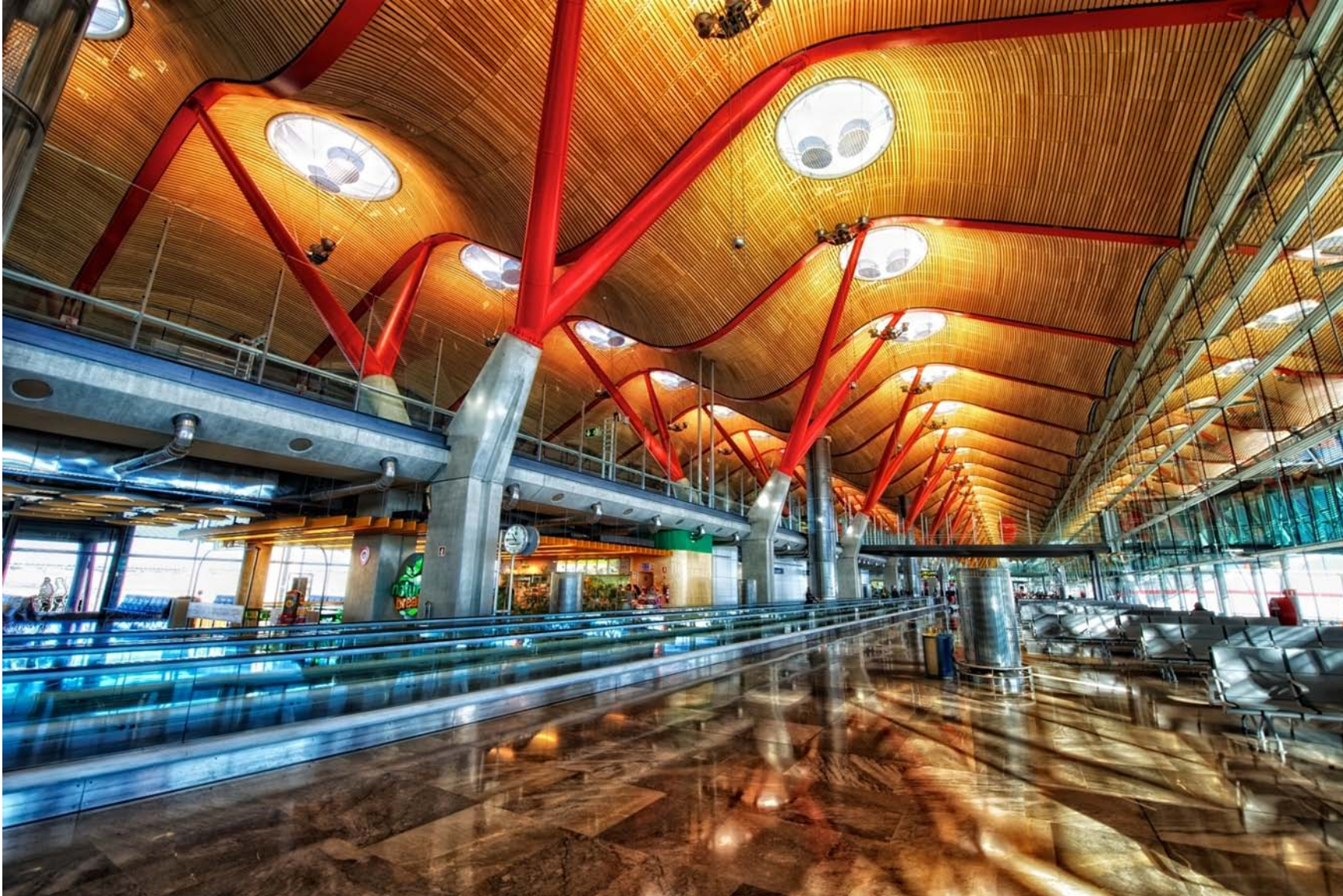
Aeroporto Madrid Barajas Forro da cobertura em bambu com tratamento antichamas
